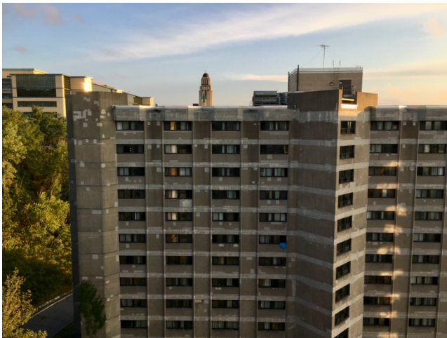
Aussicht aus dem Ost Turm des Wohnheims mit dem Bibliotheksturm der Universität im Hintergrund.
